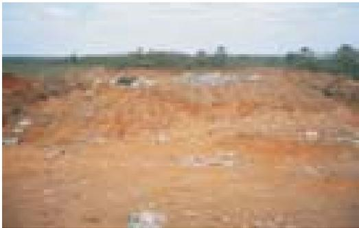
**FOTO 29/96** - ATERRO CONTROLADO DE NOVA JAGUARIBARA, UTILIZADO PARA DEPOSIÇÃO FINAL DE RESÍDUOS SÓLIDOS. NÃO CONTA COM SISTEMAS DE TRATAMENTO DE GASES E DE CHOURUME
